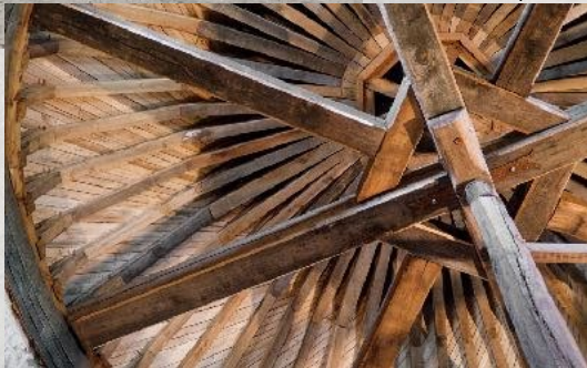
Détail de la charpente.
