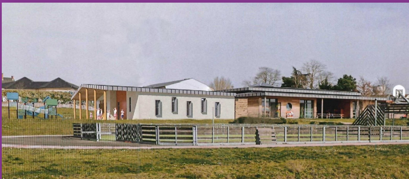
Extension de l'ACM (Centre de loisirs).
